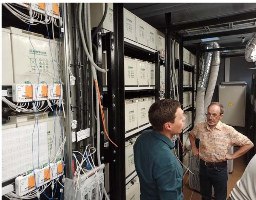
Рис. 3. Пуско-наладка системы мониторинга АКБ на одном из объектов техническими специалистами ТехноТроникс
