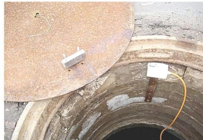
Фото 1. Смонтированный на ККС ИГД. Из «Приложения к Отзыву о тестовой эксплуатации системы адресного контроля кабельных колодцев «Вора-бей!» ООО «Технотроникс».
