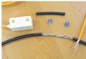
2. Затем соединить медные жилы с помощью соединителя «SCOTCHLOCK» UB2A, что очень просто. Необходимо поместить сращиваемые провода в соответствующие отверстия герметизирующей клипсы
