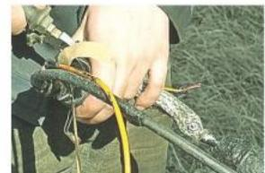
4. И, наконец, следует осуществить финишную герметизацию, тщательно обмотав место стыка лентами VM, 88T и «Armorcast» (материалы технологии ЗМ).
